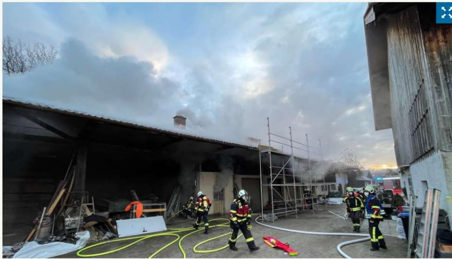
Die Baierbrunner Feuerwehr räumte, unterstützt von Einsatzkräften aus Pullach und Hohenschäftlarn, die Werkstatt leer und löschte Stück für Stück ab. © FFW Baierbrunn
